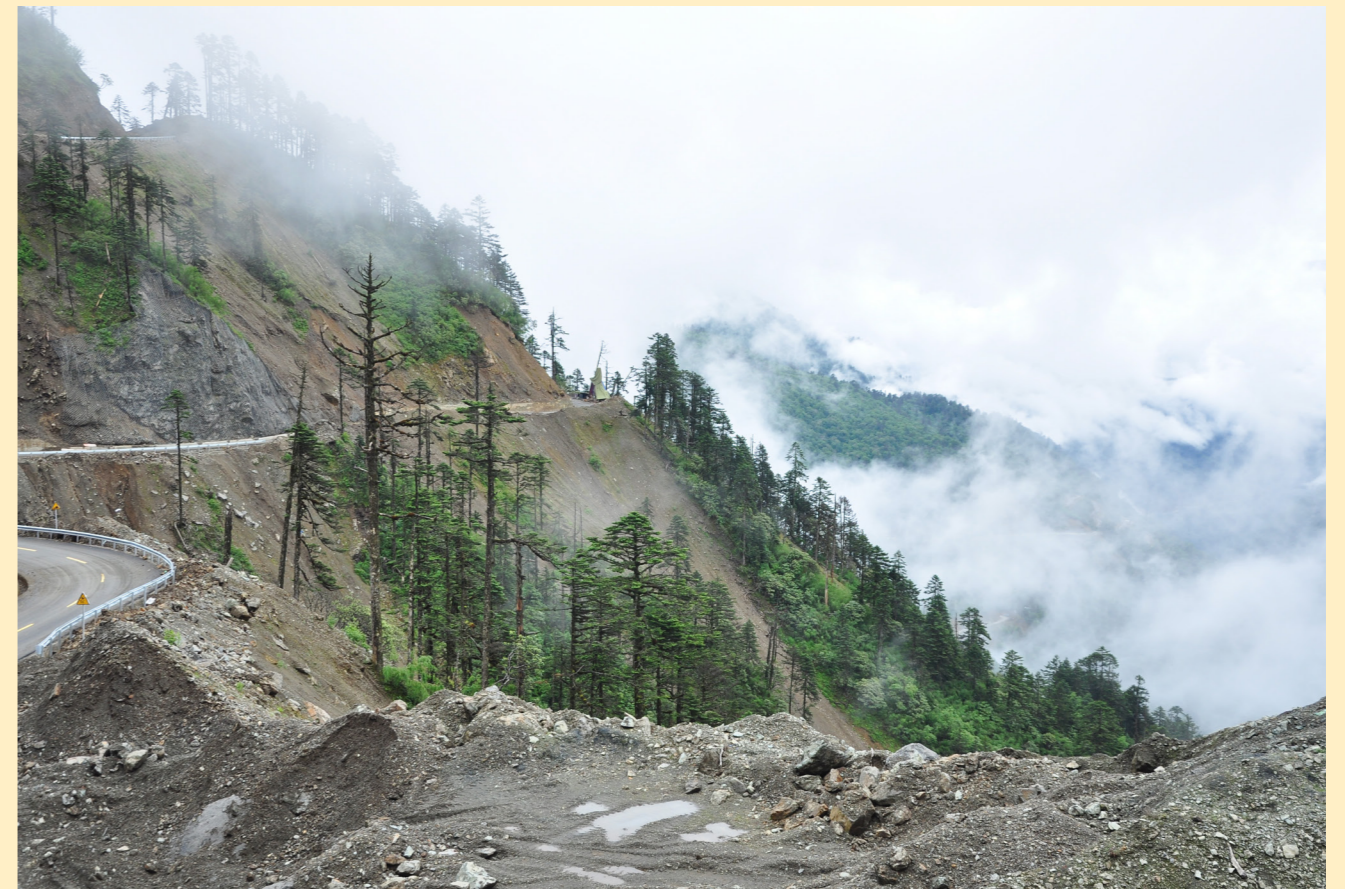
Obr. 9: Zpřístupnění odlehlých krajů si na přírodě vybírá krutou daň. Stavba silnic v horských oblastech Číny způsobuje rozsáhlé eroze svahů, které působí kolaps celých přírodních společenstev. Foto Lucie Hrůzová
